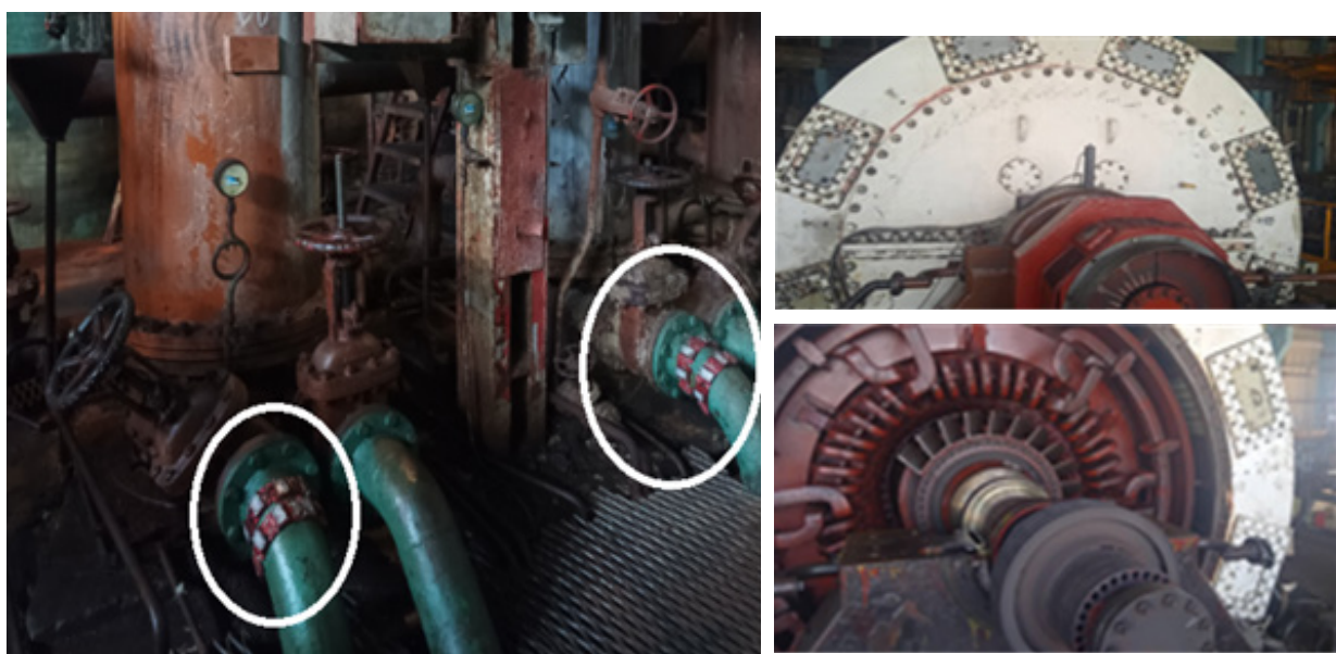
Figura 1. Sistemas de intercambio de calor beneficiados con la ubicación de dispositivos magnéticos. A) Intercambiador de aceite. B) Intercambiador de hidrógeno.
